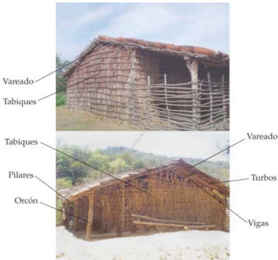
**Fig. 2:** Casa típica de las zonas secas de la provincia de Loja y las partes que la conforman.
